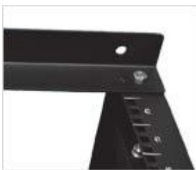
Отверстия в верхней раме стойки для крепления кабельных лотков
